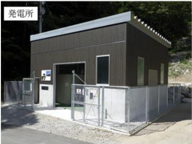
上松駒ヶ岳発電所
