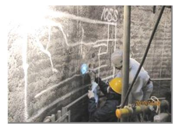
煙突の内部点検
