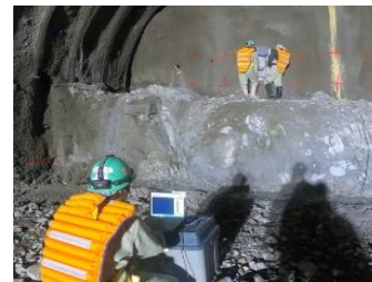
FDEMによるトンネル切羽前方探査
