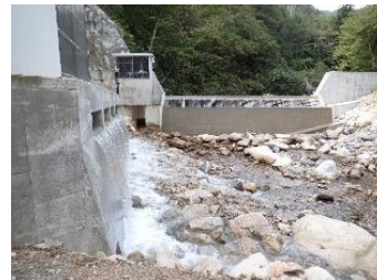
小水力発電所の建設
