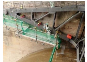
洪水吐ゲート点検
